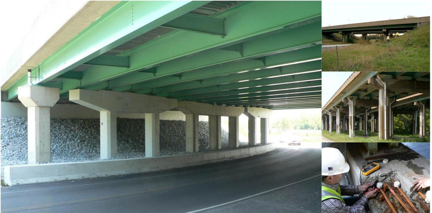
Dentro del proyecto de ampliación de las estructuras, se ha analizado el importante deterioro existente en sus elementos tras 50 años de su puesta en servicio, fruto de la utilización de sales de deshielo.
